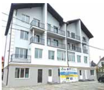
Відновлений будинок в селищі Ворзель на вулиці Квітневій, 33
