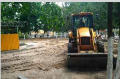
У НВК «Берізка» триває будівельний бум.
